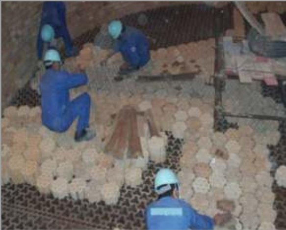
Yüksek Fırın Soba Montajı
